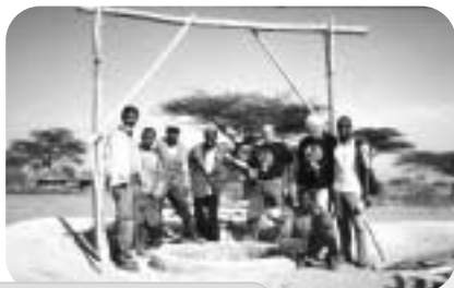
1° pozzo in costruzione
